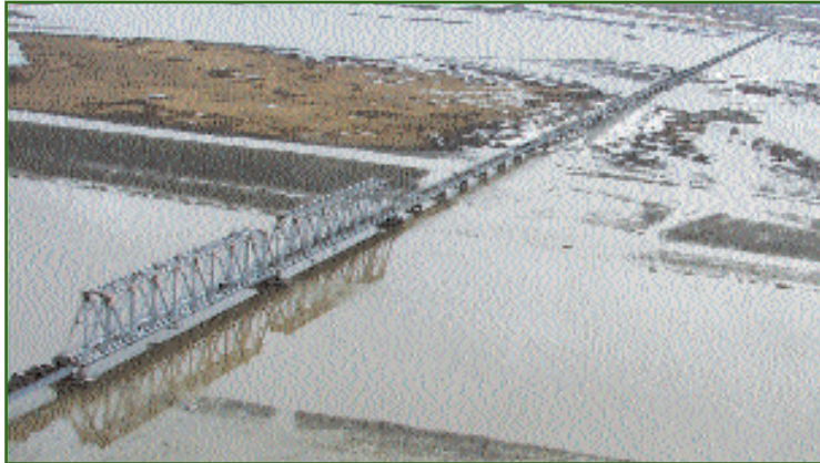
Рис. 2 Общий вид железнодорожного моста через р. Юрибей
